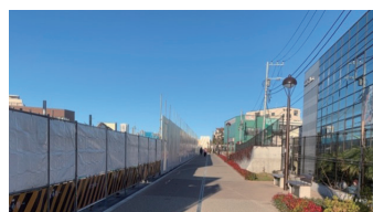
写真5 整備された通路(梅田駅付近)
